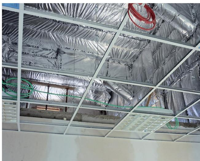
intercapedini di aria ferma su entrambi i lati e facendo ricorso a un rivestimento conclusivo con contro pareti in lastre di gesso rivestito e controsoffittature. Il risultato è stato quello di creare un caldo guscio interno in grado di preservare il calore nei freddi mesi invernali e di assicurare l'adeguato
